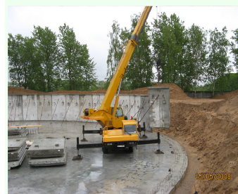
Kanalizācijas attīrīšanas ietaišu rekonstrukcijas II kārtā
