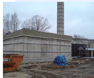
Rezervuāra būvniecība ūdensgūtnē Kalkūne
