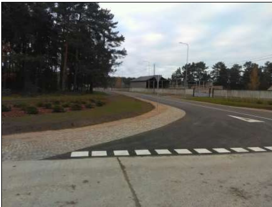
9.att. Krūmu stādīšana un kaltā granīta bruģa segums.
