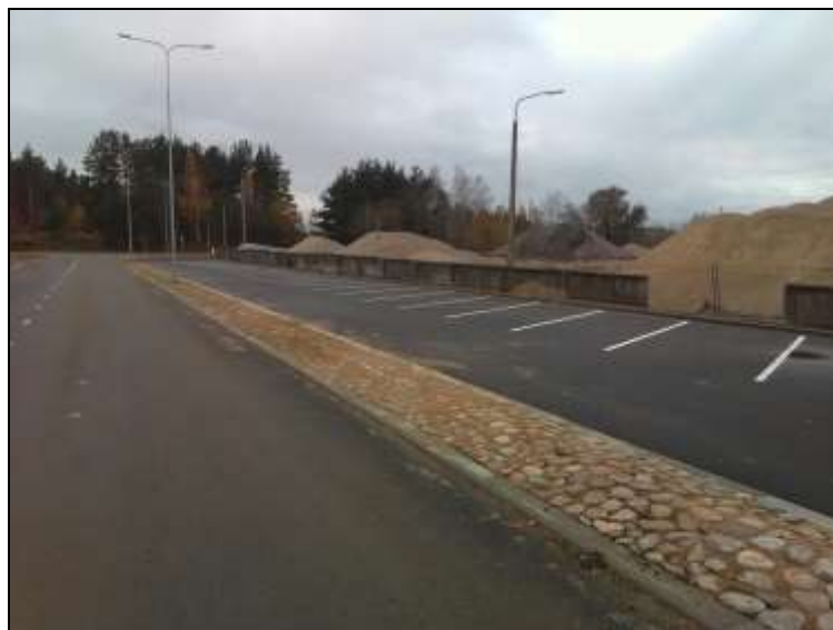
8.att. Skaldīto laukakmeņu bruģa seguma būvniecība.
