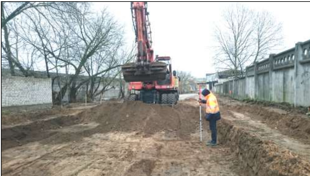
3.att. Zemes klātnes ierakuma būvniecība.
