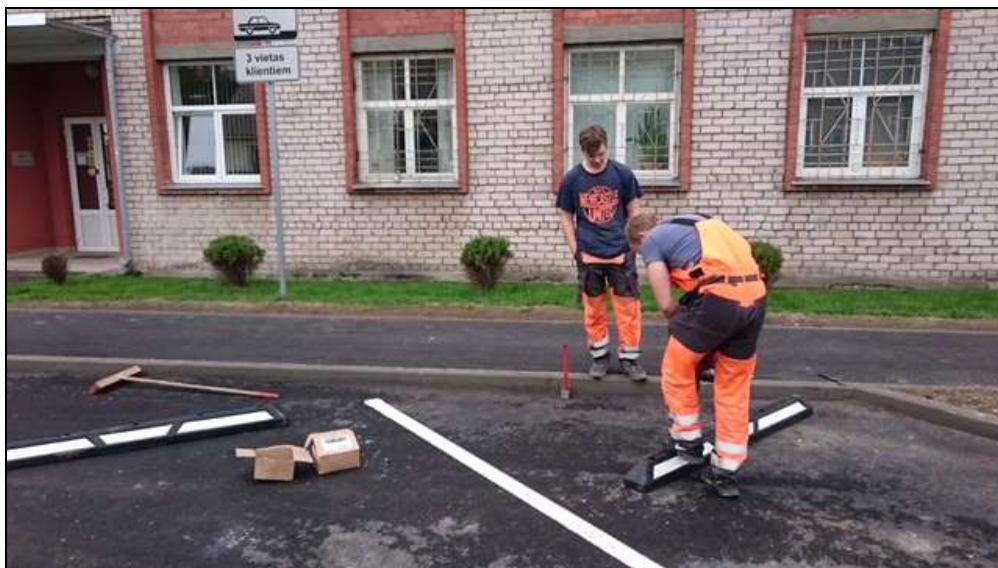
4.att. Atdures barjeras uzstādīšana.
