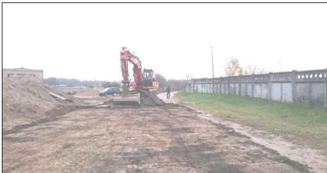
2.att. Asfaltbetona seguma demontāžas darbi.
