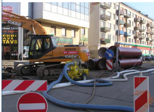
PROJEKTS “ŪDENSŠAIMNIECĪBAS ATTĪSTĪBA DAUGAVPILĪ, III KĀRTA”
